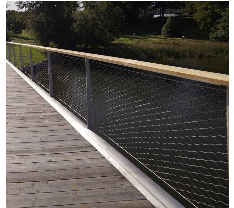
Referensbild: GC-räcke med vajermesh och toppföljare med träbeklädning.
