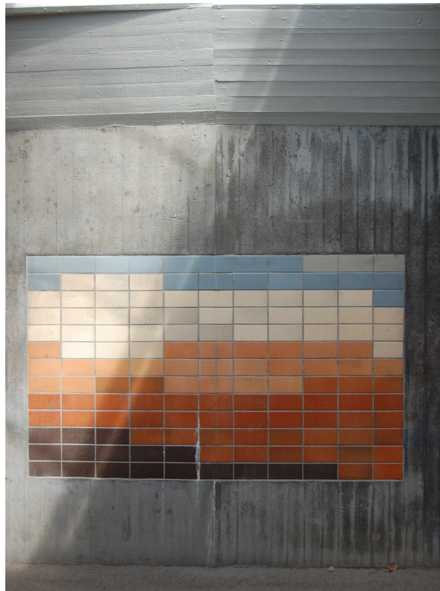
Befintlig miljö i GC-port.
