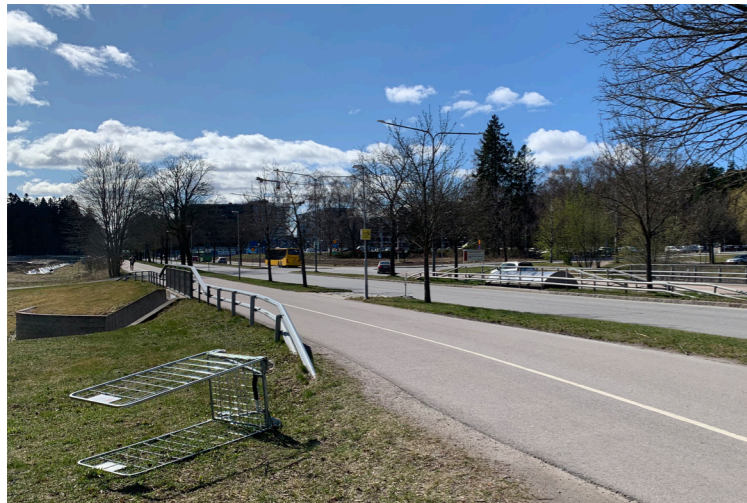
Storskalig infrastrukturmiljö vid Dag Hammarskjölds väg, A3.
