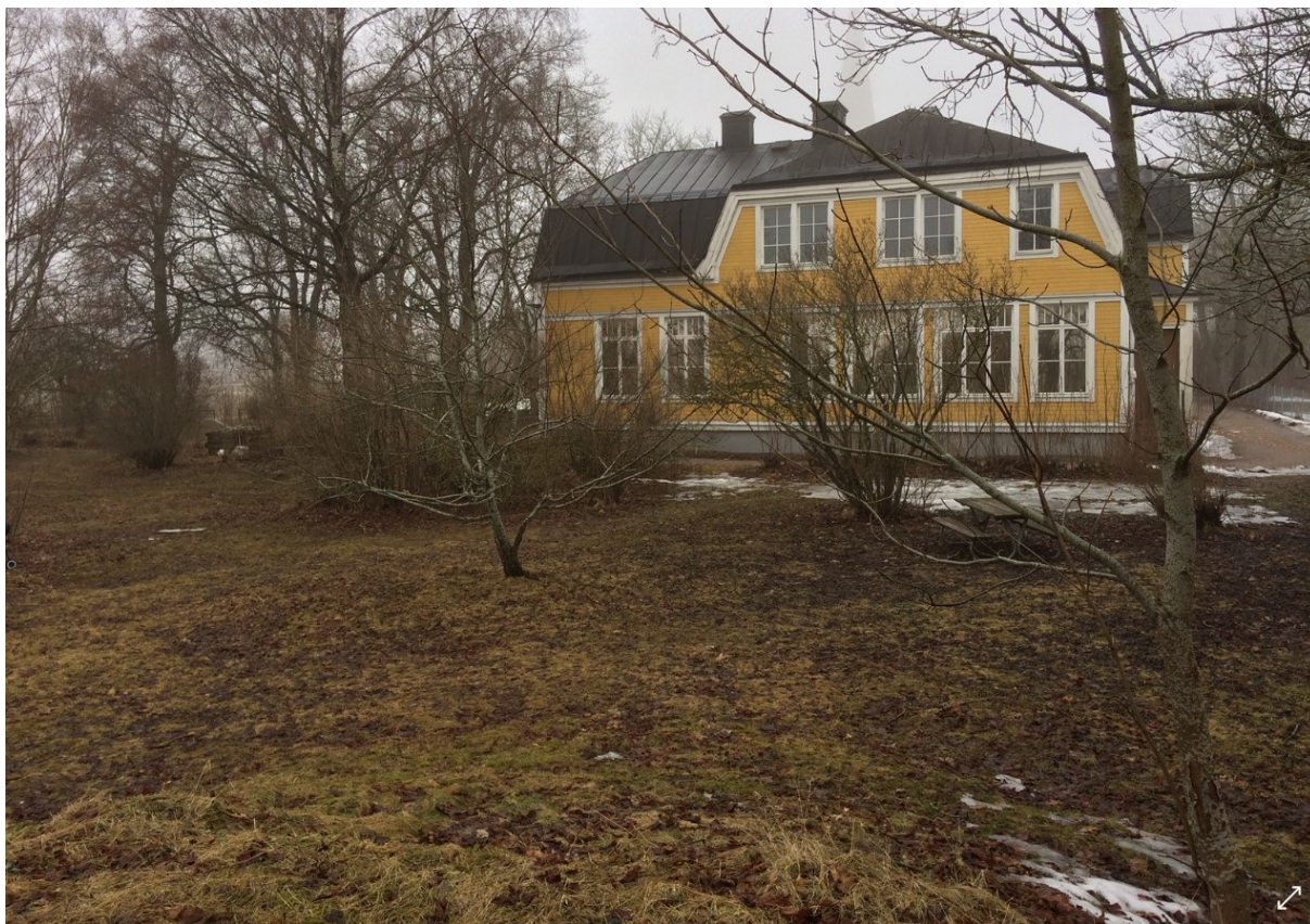
Fig. 6: Bilder från planområdet 5 april 2018. Innehåller främst gräsmatta med spridda buskar och träd. Ensartade häckar längs vissa kantzoner.
