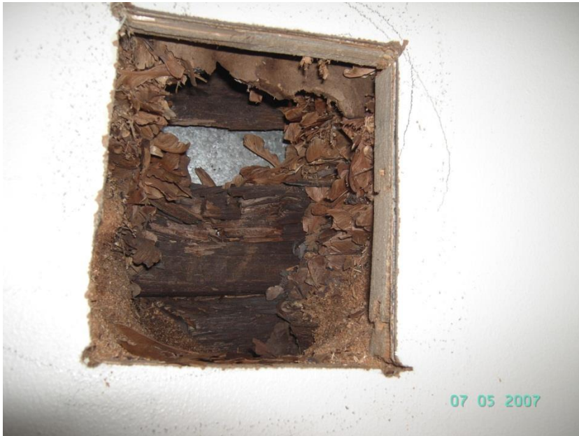
Bild 2: Sluttande tak på övre plan med isolering av en blandning av spån och växtmaterial, i Vaksala kyrkskolas lokaler.
