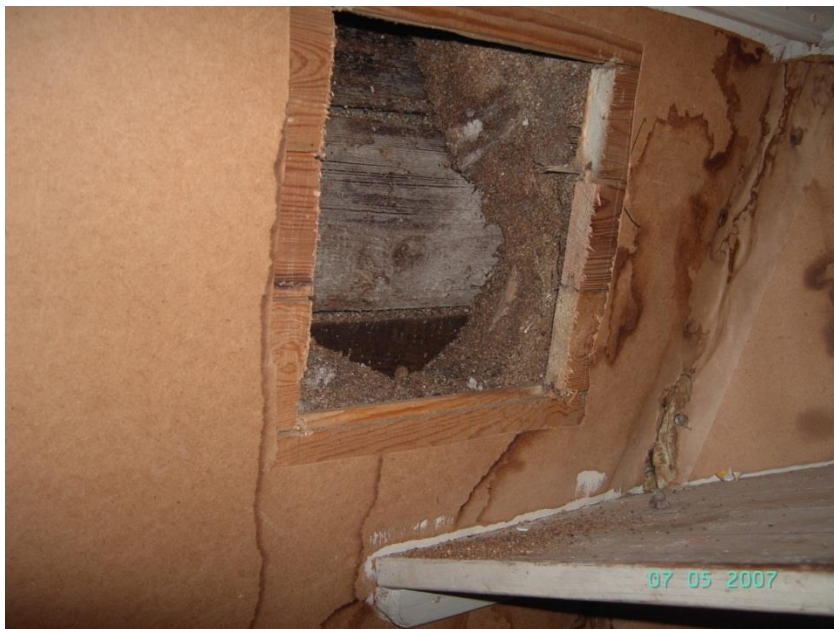
Bild 1: Sluttande tak i garderob på övre plan med isolering av spån, i Vaksala kyrkskolas lokaler.
