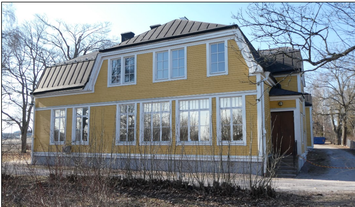
Vaksala kyrkskola sedd från sydost.
