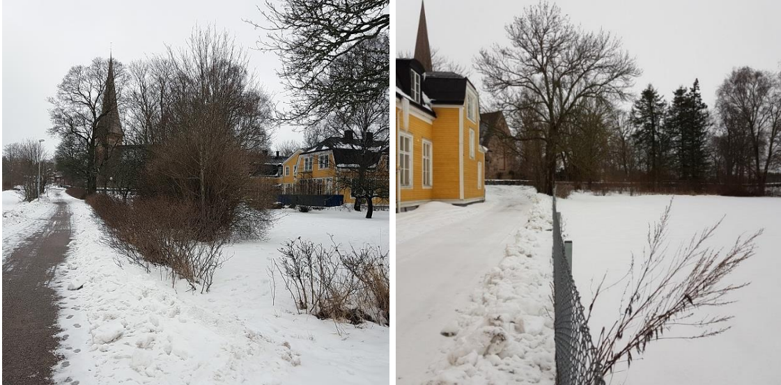
Figur 7. Grunt dike väst om byggnad (tv.). Avsaknad av dike på östra sidan mot kyrkogårdens mark (t.h.). Foto: Tyréns AB.
