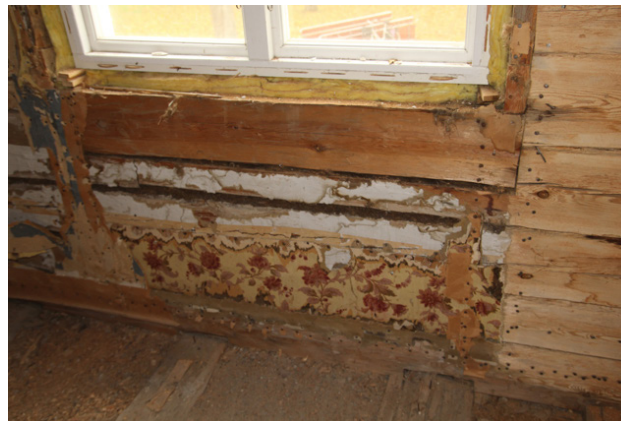
Del av ursprunglig timmervägg från 1872 innanför frontspisen mot sydväst. Här ses hur fönsterbröstningen höjt vid ombyggnaden 1912.
