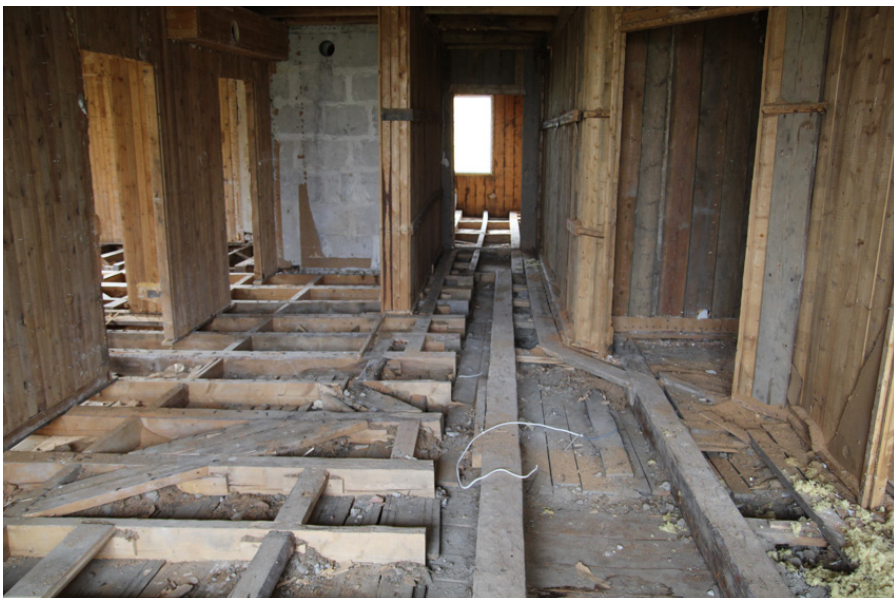
F.d. korridor i södra delen, vån 1 tr. T.v. bjälklag från tillbyggnad 1912 upplagt på underliggande timmervägg. T.h. bjälklag från 1872.
