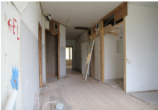
Korridor på ån. 1 tr. När senare tidars väggbeklädnad avlägsnats har den gamla pärlspontpanelen frilagts. Interiören härrör från 1912 års om- och tillbyggnad.
