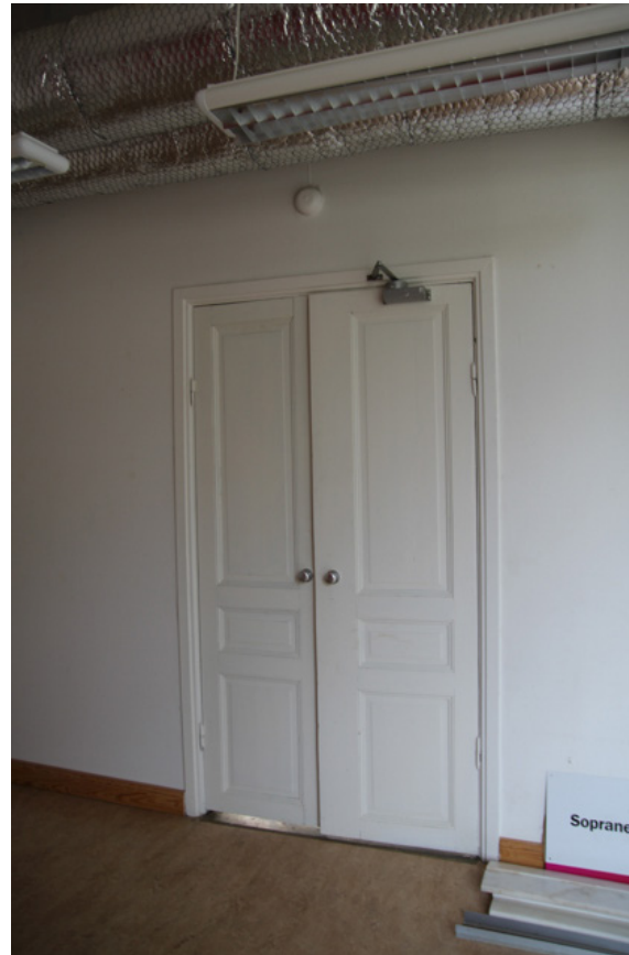
Pardörr från ombyggnaden 1912 om leder till det stora klassrummet mitt i huset på bottenvåningen . I taket syns horisontella ventilationsrör.
