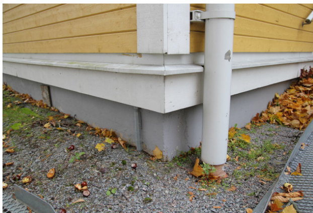
Fasaderna är tilläggsisolerade både ut- och invändigt vilket tydligt syns på panelen som ursprungligen låg i liv med betongsockeln. Panelen har grovsågad yta och plåtbeslag har modern utformning i plastbelagd fabrikslackerad plåt med lodrät droppkant.
