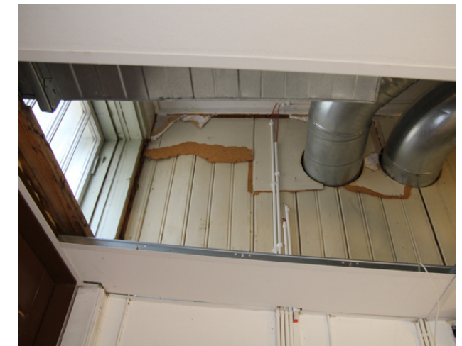
Innanför entrén på bottenvåningen frilades äldre pärlspontpanel ovanför nedpendlat undertak som döljer ventilationsrör.
