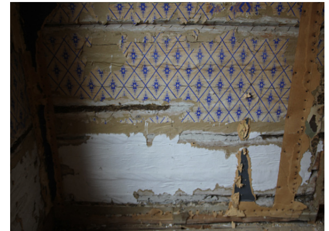
Timmerväggen i f.d. matsal vån 1 tr. Tapet och bröstning från 1870-talet. Väggen frilades sommaren 2018 i samband med konstruktionsutredningen.
