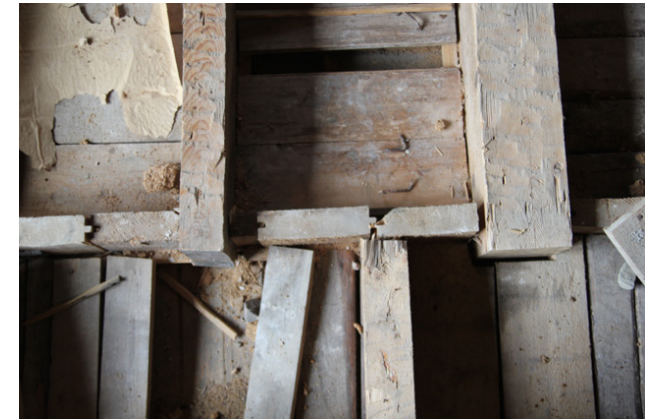
Bjälklag från 1912 som är upplagt på plankvägg.
