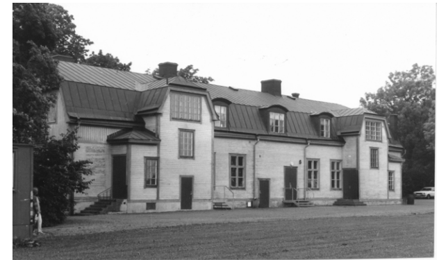
Foto från 1960-70-talet av fasad mot nordost. Källa: USA.
