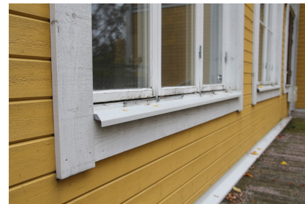
Fönsterfoder och fönstersnickerier från 1990-talets ombyggnad. Foderlisterna har grovsågad yta till skillnad från de äldre som var släthyvlade. Fönsterbleck i material och utformning lika plåten på sockelbrädan till vänster.
