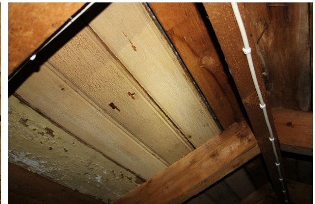
Det galvaniserade plåttaket är lagt på glespanel utan underlagspapp.
