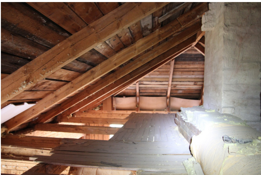
Takstolar i södra änden av huset. På bilden ses intakta hanbjälkar och putsad skorstensstock.
