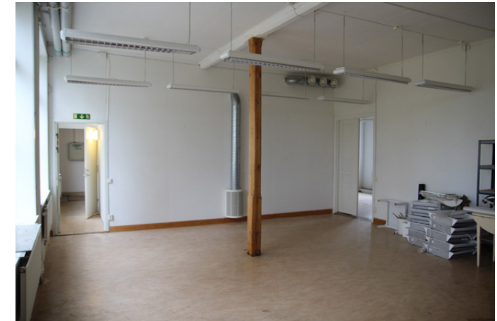
Klassrum på bottenvåningen. Äldre träpelare och pardörr i bakgrunden till höger. Ventilationsinstallation från 1990-talet .
