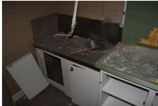
Köksinredning som hört till lärarbostad. Vån 1 tr.
