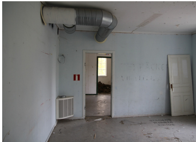
Rum på övervåningen som tidigare användes som kommunalkontor. Stora synliga ventilationsrör i taket. En äldre spegeldörr står lutad mot väggen.
