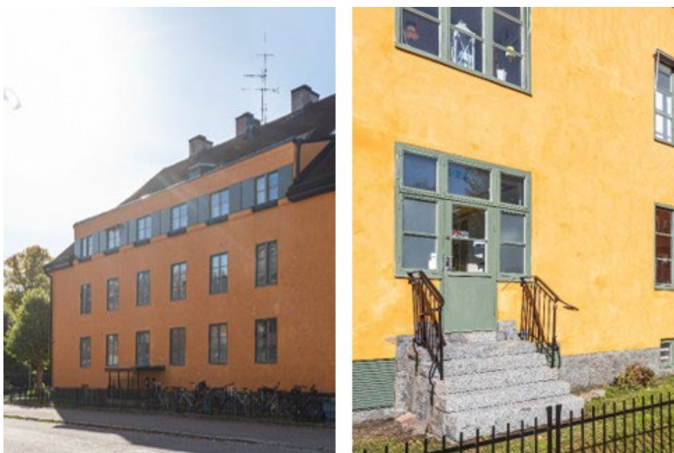
Bild 4 Trappor vid Elisabethsjukhusets östra och södra fasader.
