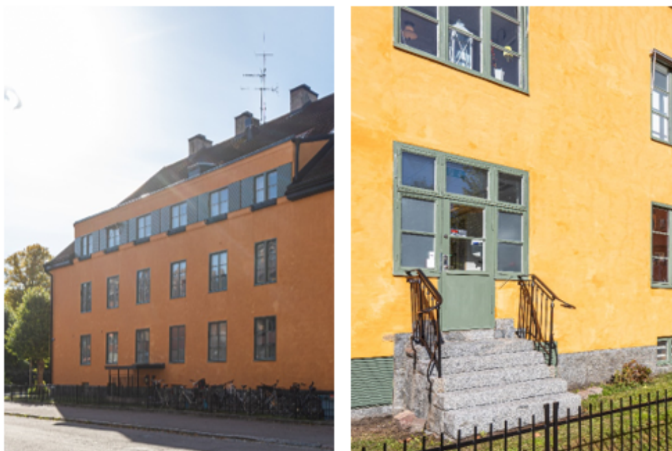
Bild 4 Trappor vid Elisabethsjukhusets östra och södra fasader.
