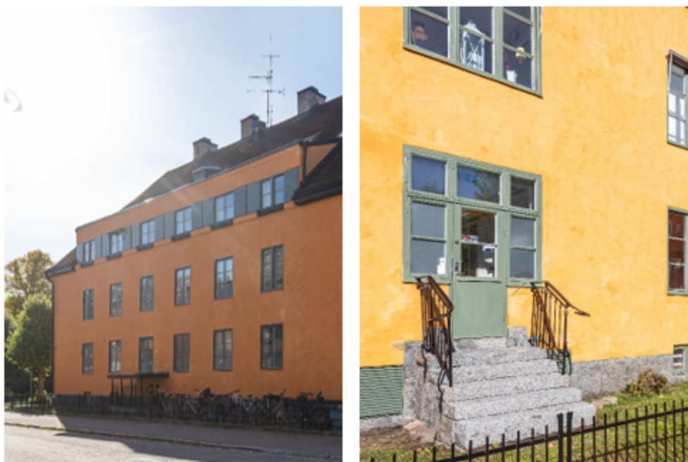
Bild 4 Trappor vid Elisabethsjukhusets östra och södra fasader.
