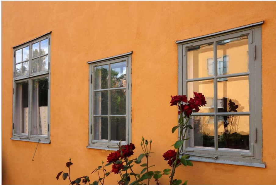
Ursprungliga fönster på den västra flygeln. Dessa fönster har en annan indelning än de som monterades vid tillbyggnaden på 1920-talet. I båda fallen är de typiska uttryck för två olika stilar: nationalromantiken och tjugotalsklassicismen.
