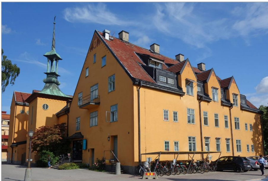
Vy från väster med den ursprungliga byggnaden från 1909-11 i förgrunden. Inför inflyttningen av Hotell Geijer inreddes vinden med ytterligare rum. Då tillkom de övre takkuporna samt ett flertal liggande takfönster.
