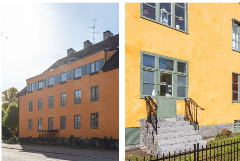
Bild 4 Trappor vid Elisabethsjukhusets östra och södra fasader.
