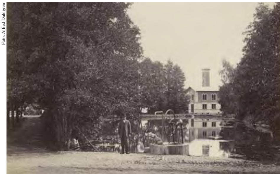
Sandvikskällan 1892. Bilden tagen från väster mot dammen och pumphuset.
