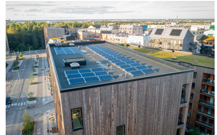
Exempel på solceller på taket.
