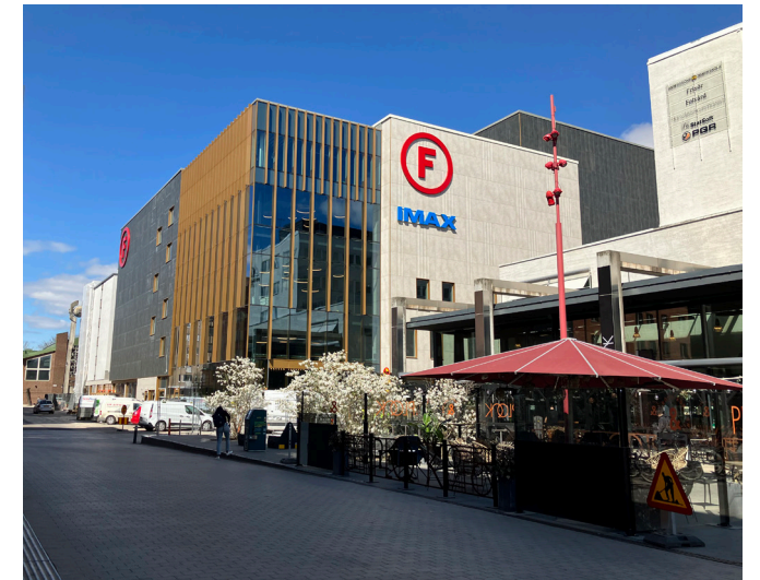
Ny bebyggelse i befintlig struktur längs Dragarbrunnsgatan.
