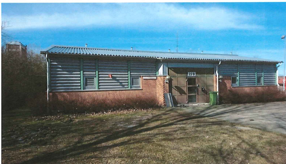
Byggnad Grovlektion exteriör
