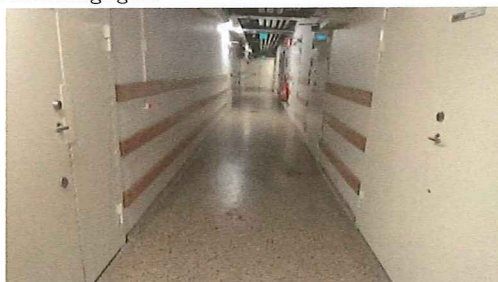
Gemensam förbindelsegång källare
