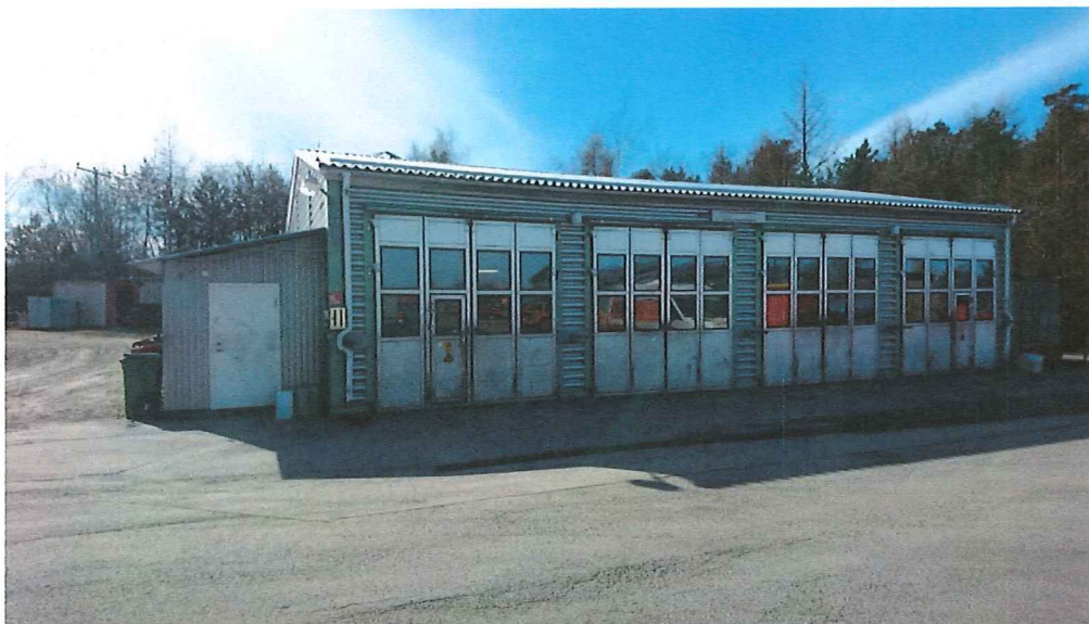
Byggnad Reparationsverkstad exterier
