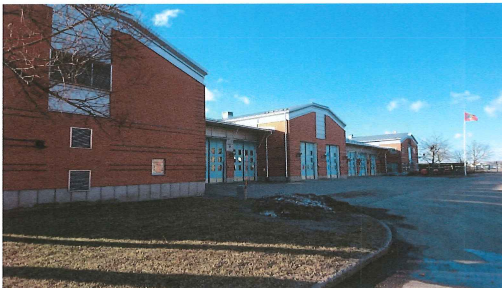
Byggnad Brandstation, exteriör fasad öster med garageportar
