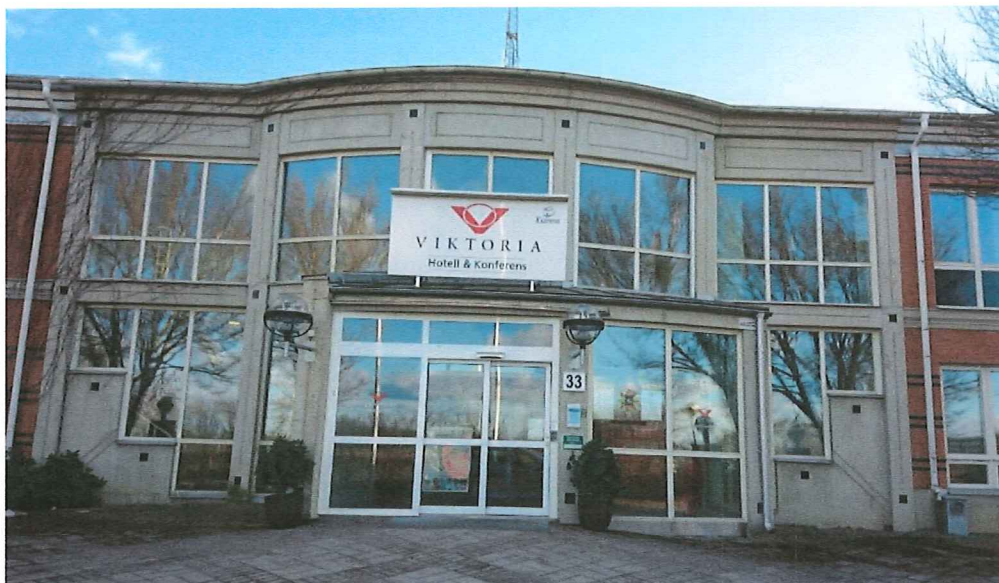
Byggnad kontorsbus, exteriör, fasad gemensam entré
