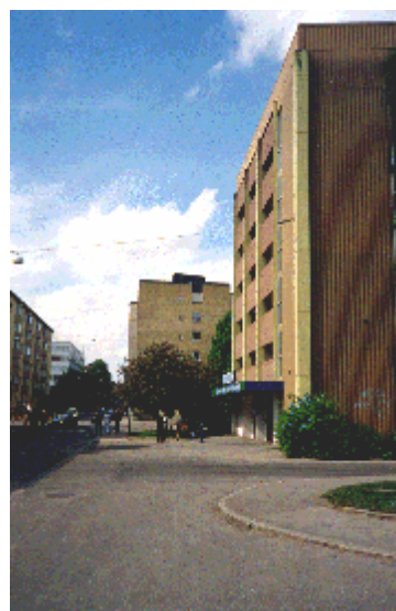
Fasad mot Dragarbrunnsgatan.
