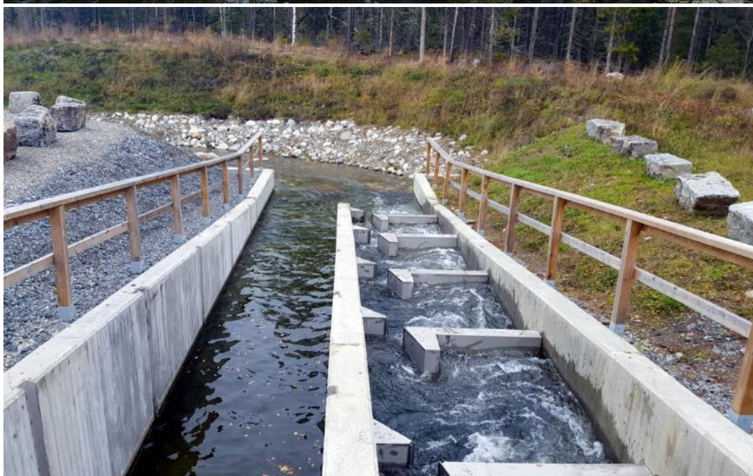
Figur 42. Ovan: Ett överlöp/upptröskling i Vendelån vid Vendelsjöns utlopp. Nedan: En slitsränna i Billstaån, Östersund. Fisken vandrar genom de smala slitsarna till höger i bild.
