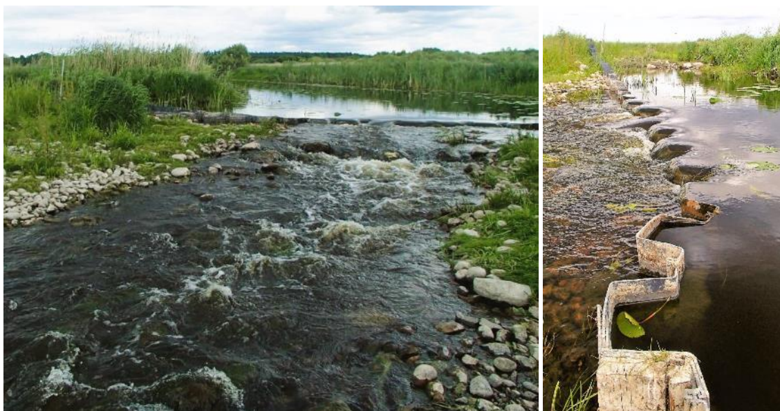
Figur 37. Foto över Vendelsjöns nya utlopp med en plastspont med v-utskov (t.h.) och strömsträcka nedströms av naturgrus och sten (t.v.).
