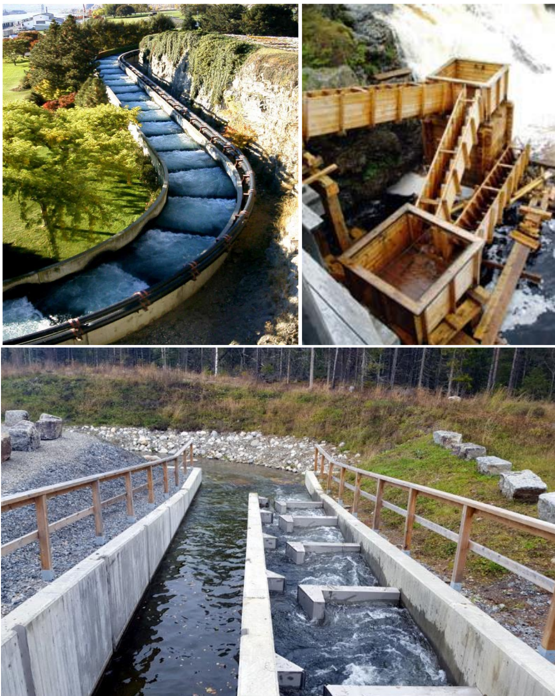
Figur 40. Ovan t.v: Bassängtrappa i Columbiafloden, USA (Havs- och vattenmyndigheten, 2013a). Ovan t.h: Denilränna/motströmsränna. Lameller sitter i 45° vinkel mot botten och dess öppning bör vara minst 20 cm, helst 30 cm (Naturvårdsverket och Fiskeriverket, 2008). Nedan: Slitsränna i Billstaån, Östersund. Fisken vandrar genom de smala slitsarna till höger i bild. Foto: WRS.
