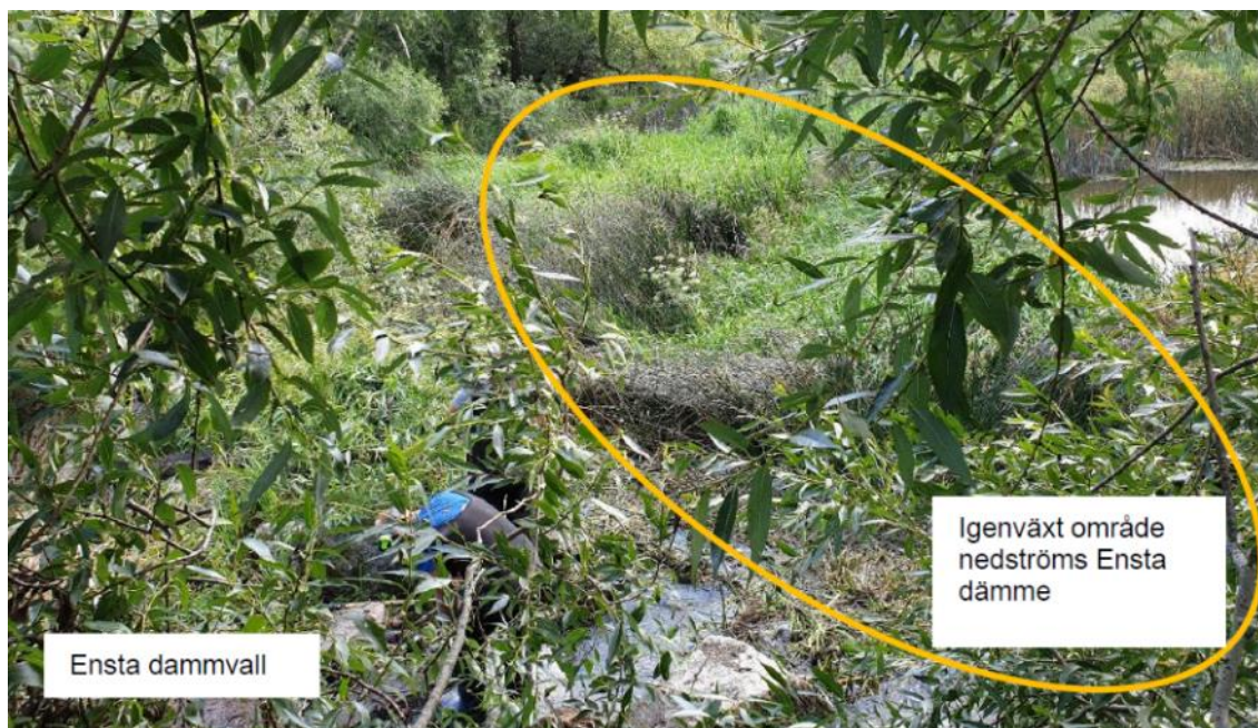
Figur 34. Igenväxning nedströms Ensta damm. Foto: Tyréns och TerraLimno Gruppen (2021).
