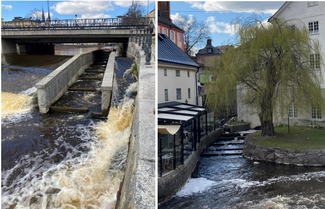
Figur 31. T.v. Slitsränna vid Islandsfallet som togs i bruk 2008. Ökad anlockning till fiskvägen sker genom flödet längst till höger. Till vänster i bild ses skibordet. T.h. Kvarnfallet vid Upplandsmuseet. Fiskvägen består av flera delar. I bild ses den nedersta slitsrännan och denilrännan. Därefter fortsätter fiskvägen i ett omlöp och ytterligare en slitsränna.
