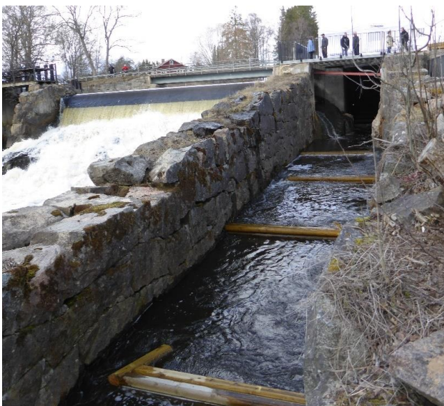
Figur 32. 2017 anlades en slitsränna vid Ulva kvarn.
