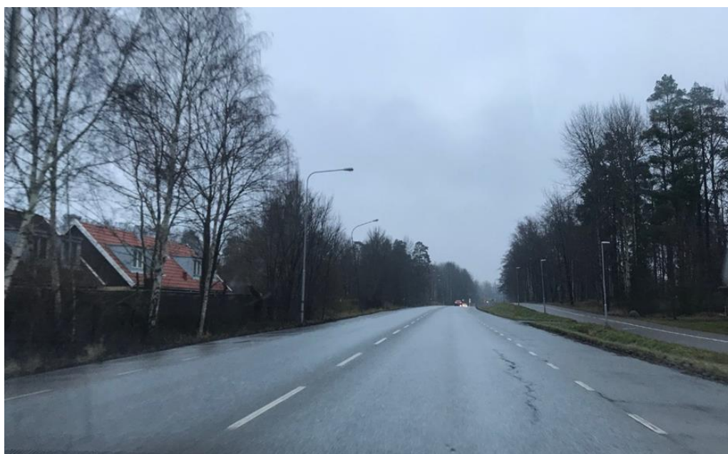
Bild 6 Vårdsättravägen sedd från söder. Vägen kommer att breddas. Kollektivtrafikstråket är tänkt att placeras i mitten av gatuutrymmet. Visst intrång kommer att ske på några småhusfastigheter. Ett antal träd kommer att tas bort, men biotopskyddade träd ersätts av nya.
