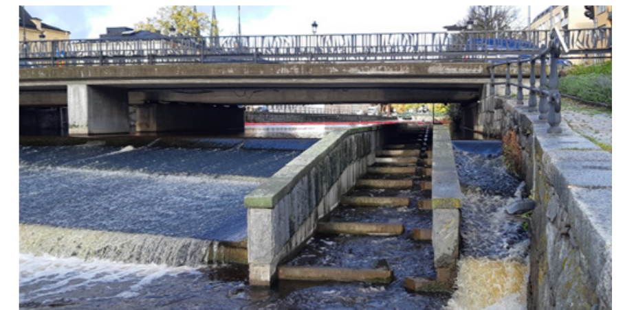
Figur 18. Asptrappan under Islandsfallet. Foto WSP Sverige AB.
