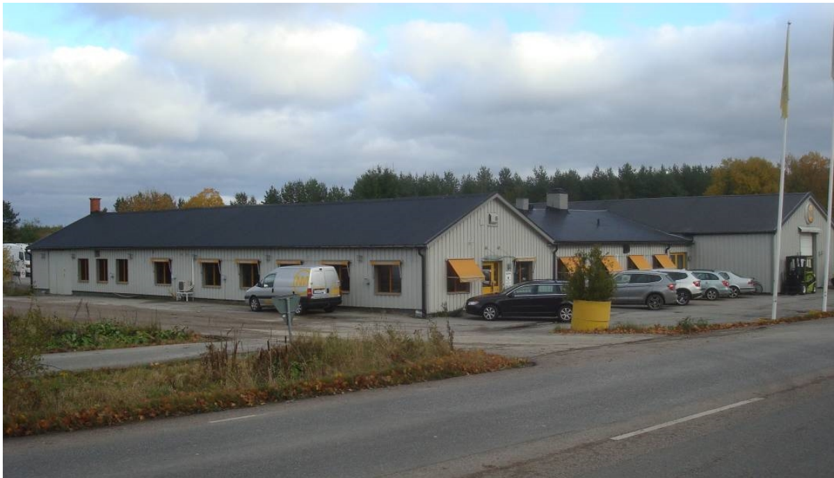
Näsström Maskin AB sett från Iduns väg.
