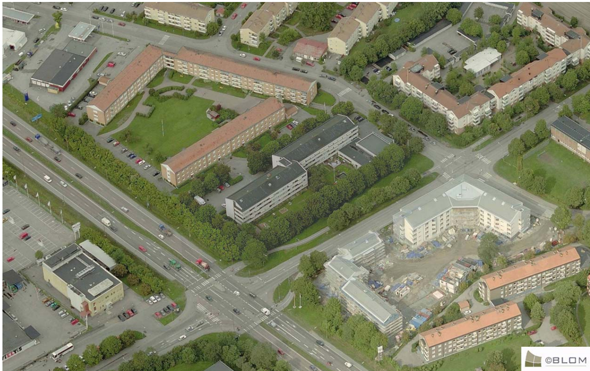
Nuläge: Vy över kvarteret och Johannelundsgården från söder, korsningen Tycho Hedéns väg–Hjalmar Brantingsgatan. Flygbilden från 2007 visar bl a vårdboendet i kv Hasseln under uppförande.
