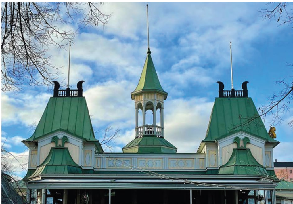
Bild 12 - Flustrets karaktäristiska taksiluett med hörntorn och mittorn. Dekoren är både original och återskapad i form av bland annat listverk, balustrader, fyllningsmarkeringar, ljusramp och akroterier på tornhuvorna, Libeck antikvarie.
