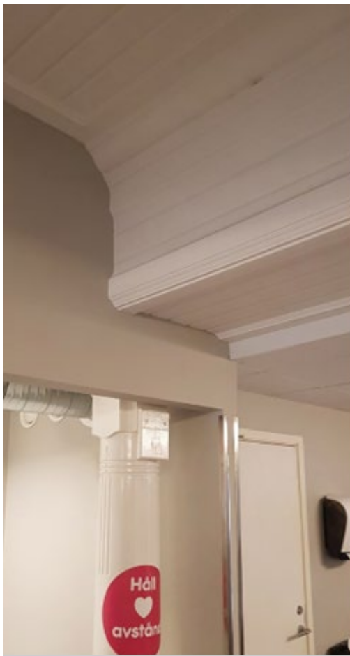
Bild 17 - Detalj av balkar och tak klädda i trä och gjutjärnspelare, Sweco
