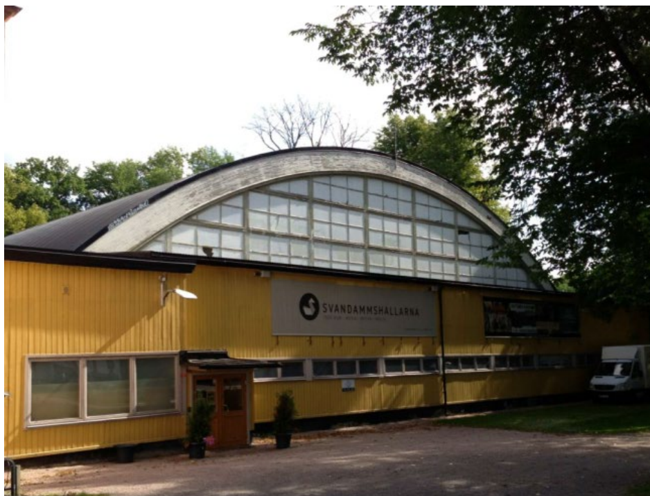
Bild 24 - Bollhusets framsida mot väster, Stockholms byggnadsantikvarier AB, 2013
