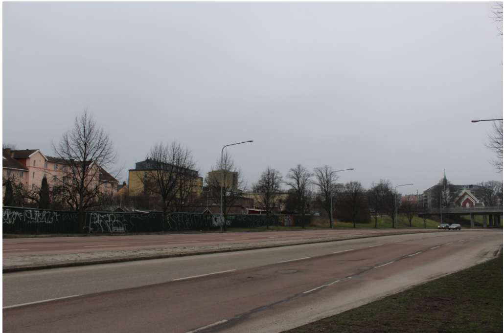
Vy från Luthagesplanaden i höjd med Väderkvarnsgatan, där byggnadsdelen i tio våningar blir synlig mitt i bilden.
