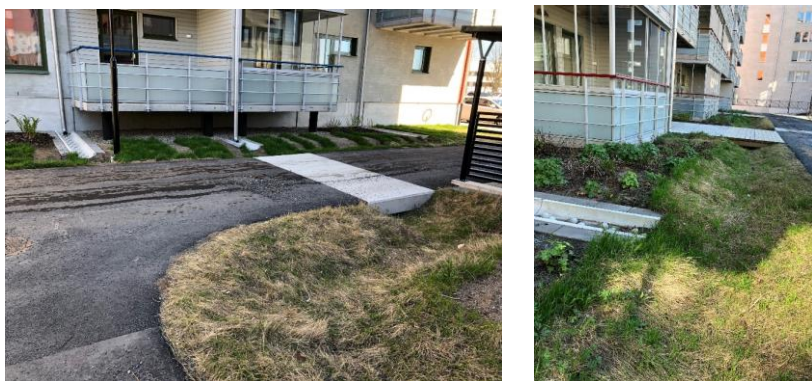
Figur 9. Exempel från Umeå på avledning av takdagvatten till gröna ytor
