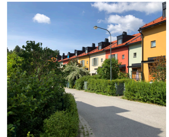
Grönka i gatan Häckarna är gränsen mellan fastigheterna och kvartersgatan.
