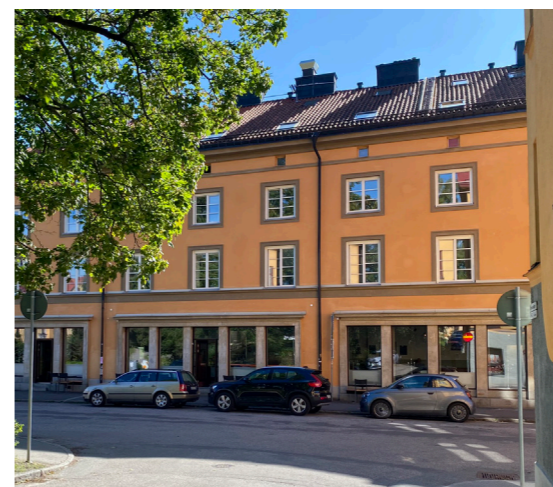
Fasadindelning Exempel på hur en bottenvåning tydligt särskiljer sig från de ovanliggande våningarna.
