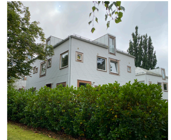
Volym Här ett exempel på spännande utformning av tak och takcupor/frontespiser.
