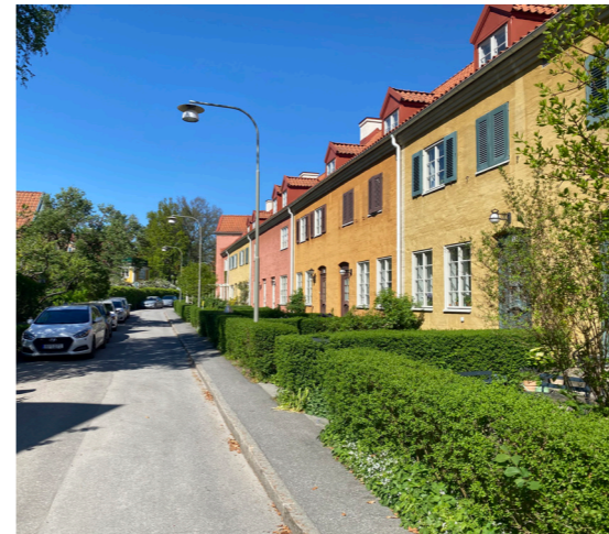
Grönt gaturum Radhus med tydlig gräns mot gata/cykelstråk. Samma volym som varierar i kulör efter varje par enheter.
