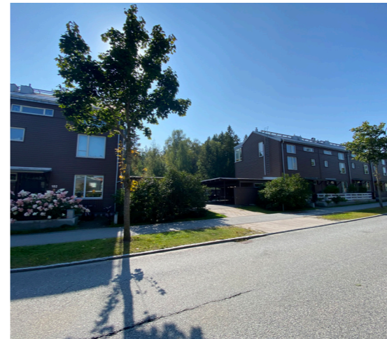
Radhusparkeringen syns endast som ett släpp mellan radhuslängorna. Plats ges för plantering eller sittgrupp framför parkeringslösning.
