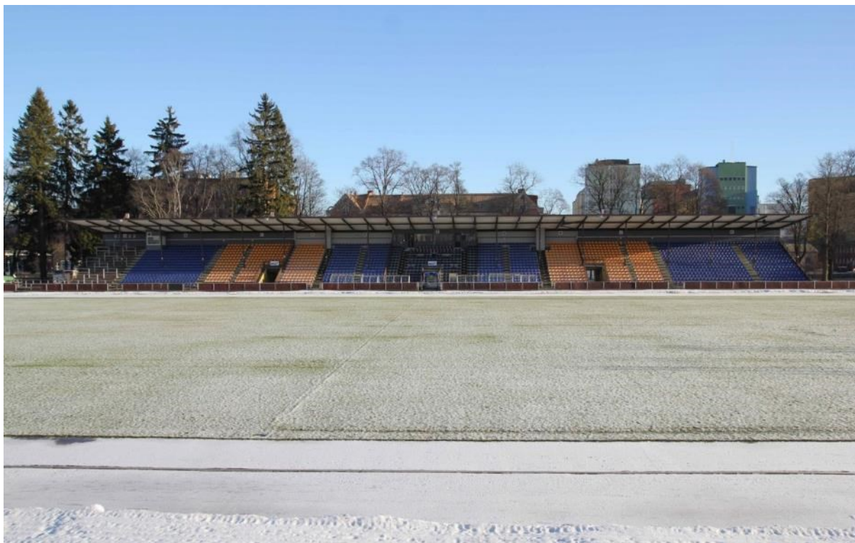
Den befintliga huvudläktaren för fotboll och friidrott ligger utmed Fyrisån. I bakgrunden syns Lantmännens livsmedelsindustri i Kungsängen.
