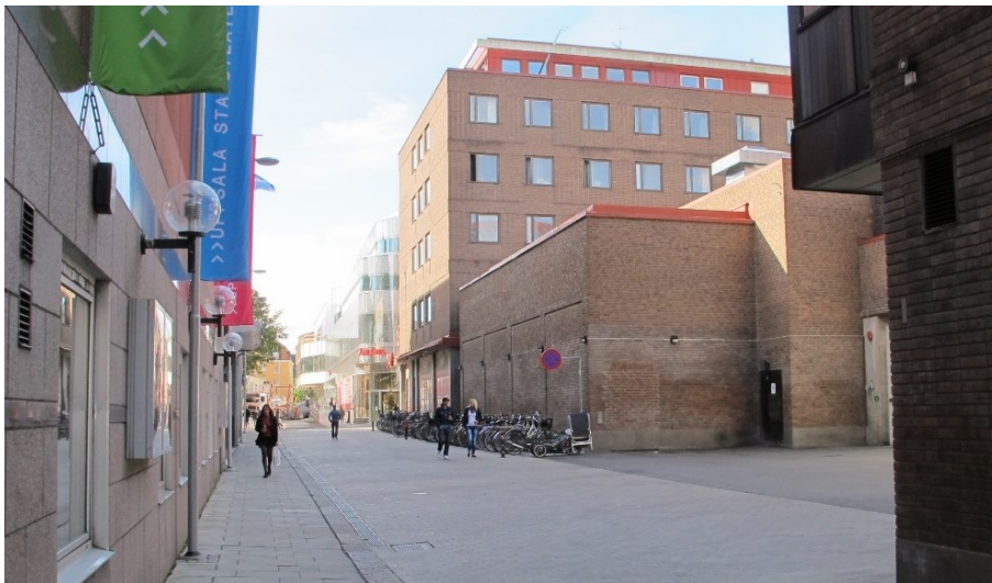
Smedsgränd, från Kungsgatan. Inlastning och garage i kvarteret Sala till höger.
