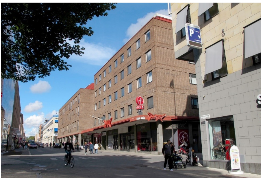
Livförskjutningar mot Dragarbrunnsgatan. Att hörnhuset är något indraget från gatan ger en variation i gaturummet.
