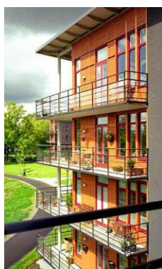
Bilderna till höger är exempel på träfasader (Sweco Architects, fotograf: Felix Gerlach samt Peter de Ru).
