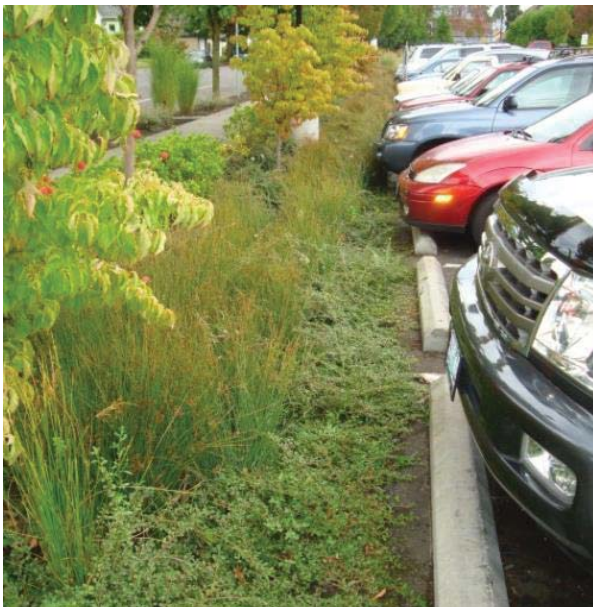
Figur 9. Exempel på utformning av svackdiken med vegetation intill parkeringsyta
