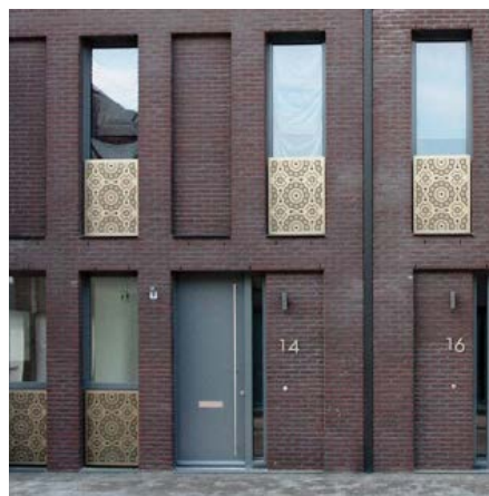
5. EXEMPEL PÅ DETALJERING AV BALKONGFRONTER
