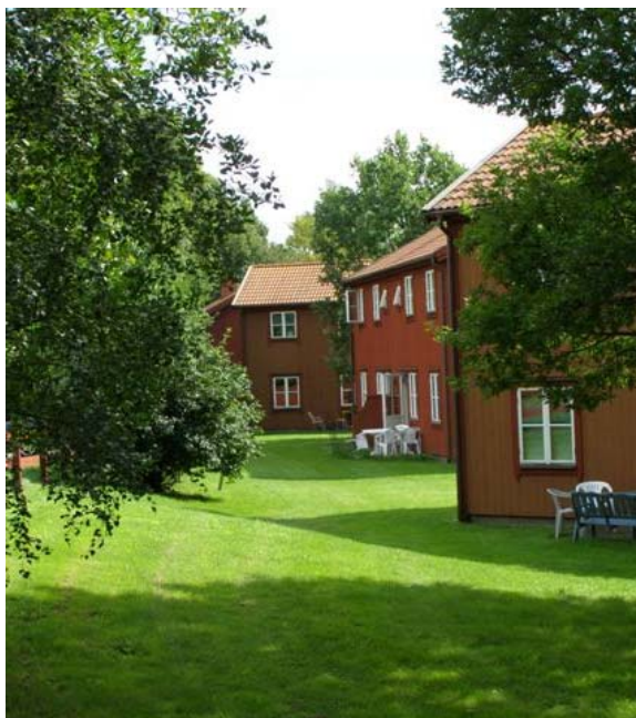
Kalmar. Träfasader med finlemmad panel, enkla detaljer kring fönster mm. Tegelröda takkupor.
