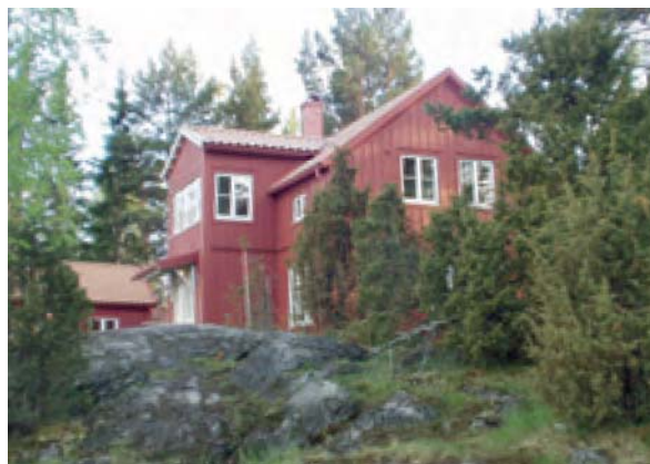
Segersäng. Naturlig markbehandling av tomter. Återhållsamt takutsprång, förhöjt fasadliv.
