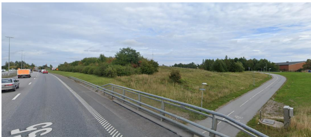
Figur 5. Foto över område närmast väg 55 tagen vid planområdets norra kant i östlig riktning. © 2022 Google.
