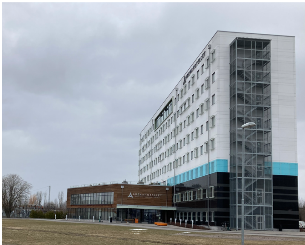
Figur 7. Arenahotellet i vitt med en sockel i svart och turkost. Entrén markeras genom att förläggas i en utskjutande byggnadsdel som är uppförd i trä och glas. Hotellets kortsida domineras av den utanpåliggande brandtrappan.
