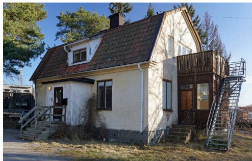
Fastighet Flogsta 11:12, fasad mot öster.
