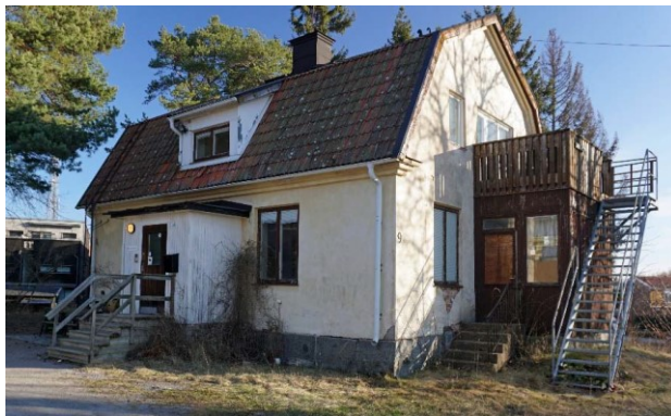
Fastighet 11:71, fasad mot söder.
