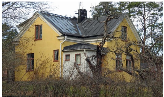
Fastighet 11:12, fasad mot öster.
