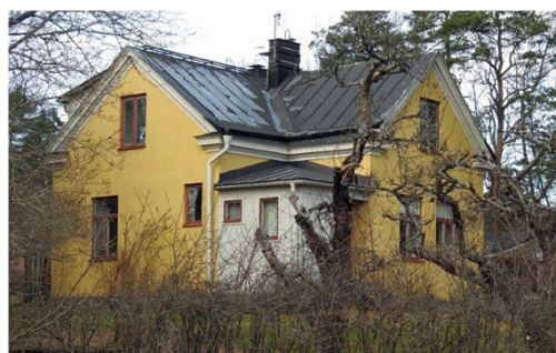
Fastighet Flogsta 11:71, fasad mot söder.
