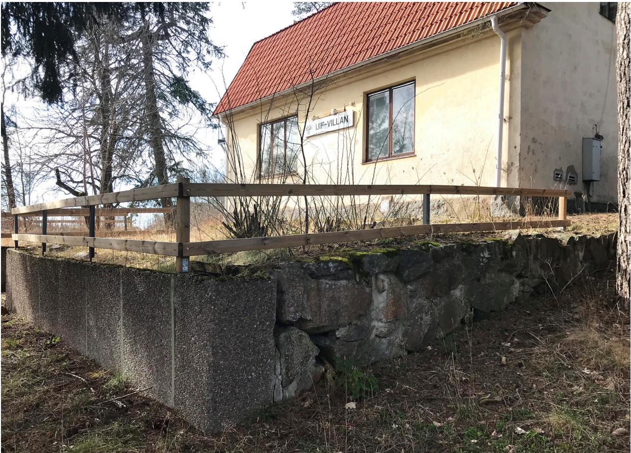
Bild 13. Troligtvis ursprunglig terrassmur av natursten och bruk, som senare byggts på med betongelement med frilagd ballast av sjösten.
