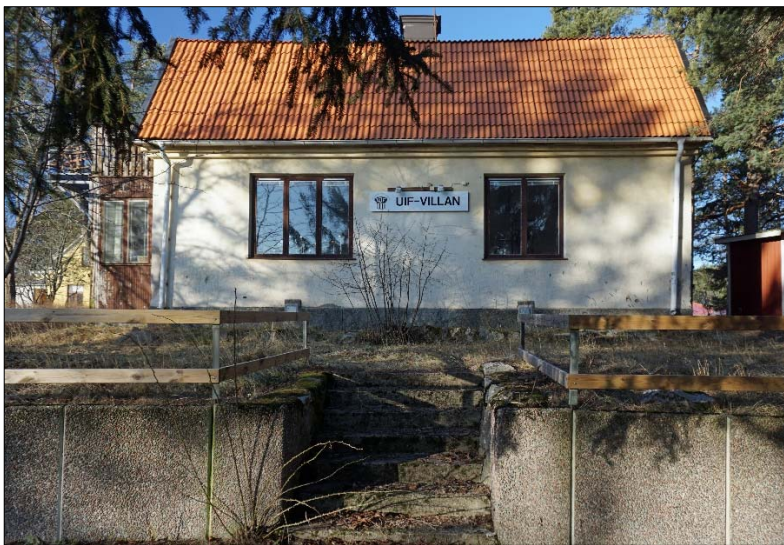
Längsida mot öster med terrasseringens stödmur i förgrunden.
