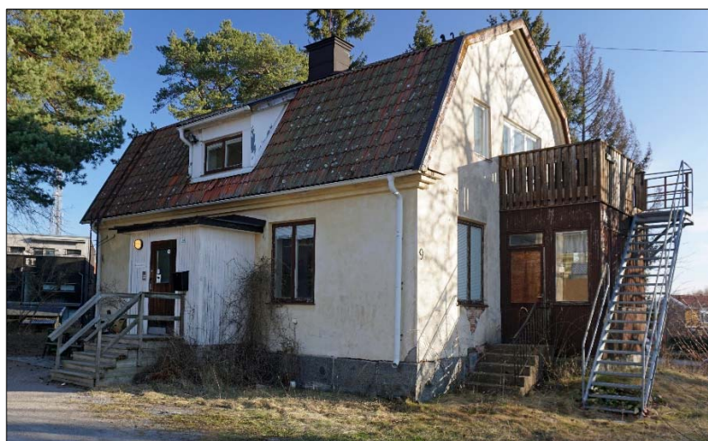
Byggnaden från söder med förstuga och vindskupa på långsidan och veranda med terrass på gaveln mot öster.
