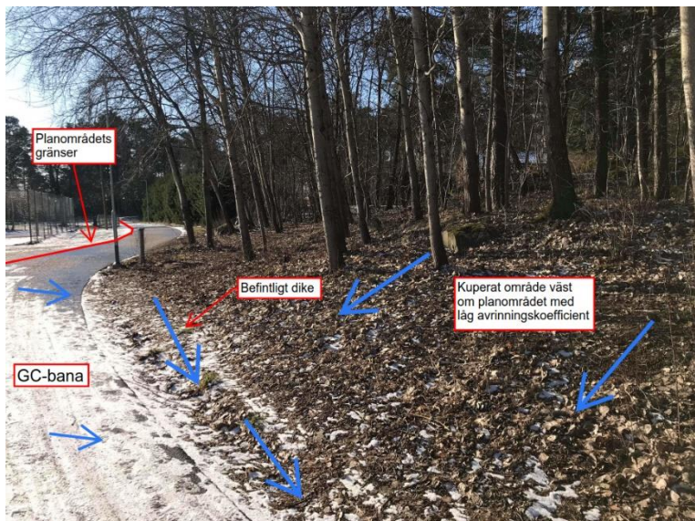
Figur 20 - Fotot visar söderut och visar ett avskärande dike som ligger längs norra delen av gång- och cykelbanan och minskar belastning från området i väst till utredningsområdet. Området uppströms har låg avrinningskoefficient och vatten kan lätt infiltreras i mark (Foto: Sweco, 2020)
