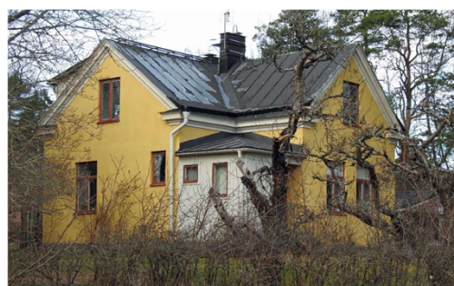
Fastighet Flogsta 11:71, fasad mot söder.
