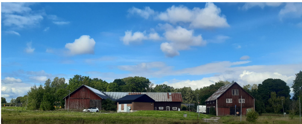
Figur 15: Ekonomibyggnader och tryckstegringsstation inom planområdet.
