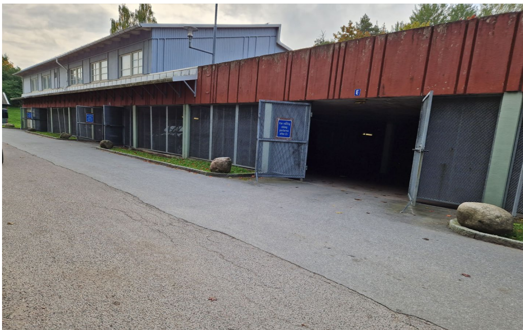
Figur 7. Parkeringsanläggning inom planområdet, belägen mellan Bandstolsvägen och Hugo Alfvéns väg.
