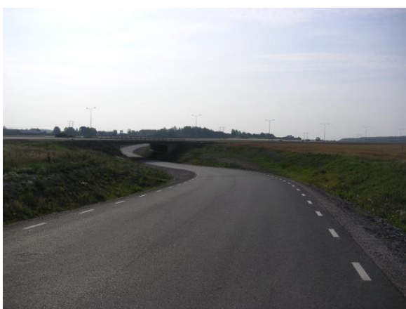
Väg 652 passerar under ny E4 i östlig riktning
