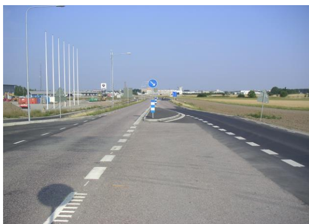
Väg 282 i riktning mot staden
