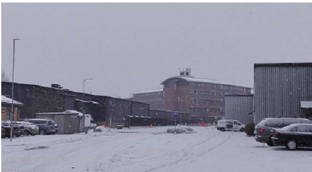
Figur 17 Seminariegatan med Galdermas byggnad 4 på vänster sida.
