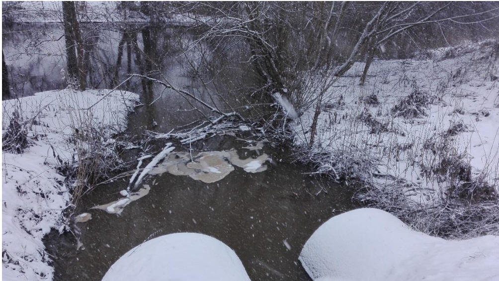
Figur 16 Librobäckens mynning i Fyrisån. De två trummorna under gångbron syns i den nedre delen av bilden.
