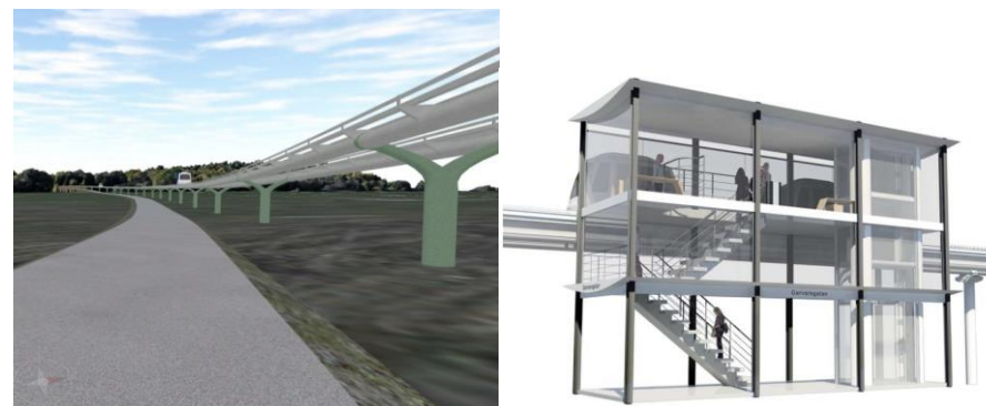
Figur 14. Exempel på utformning av pelare och upphöjd spårtaxibana bredvid gång- och cykelväg samt exempel på typstation med tre vagnsplatser.
