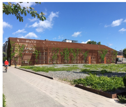
Exempel på inbyggd nätstation, Kungsängen Uppsala
