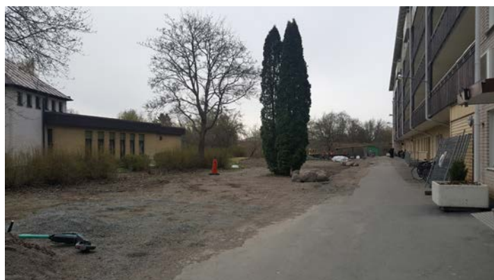
Södra skivhusets gårdssida under omdaning. Årsta kyrka till vänster.
