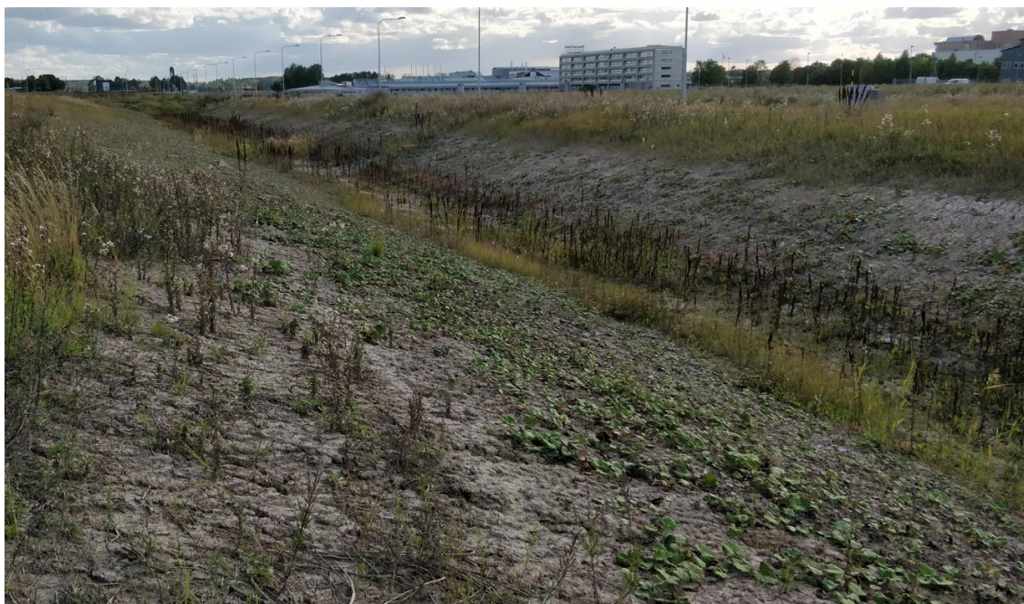
Figur 12. Exempel på hur ett större svackdike kan anläggas i anslutning till en gata. Bilden är tagen i Uppsala av Sweco.
