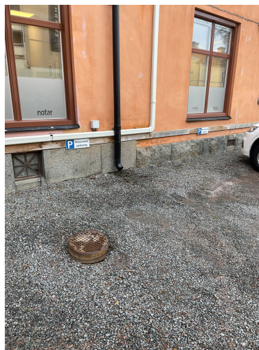
Stuprör vilket leder vatten ut på grusparkeringen
