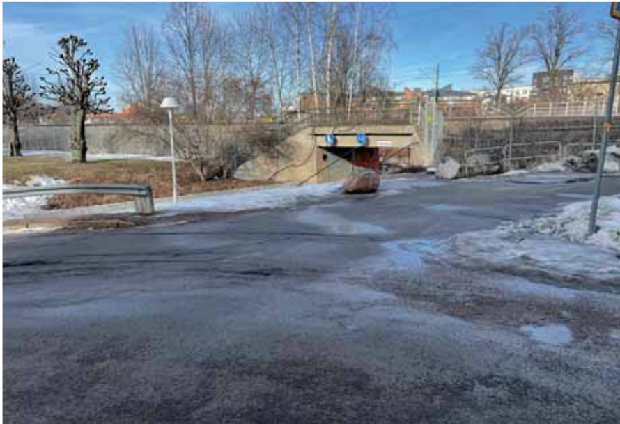
Figur 16 Anslutande gång- och cykelstråk mot Skolgatan.
