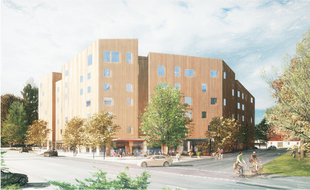
Entrén till Kv. Språkmästaren från Vårdsätravägen.
